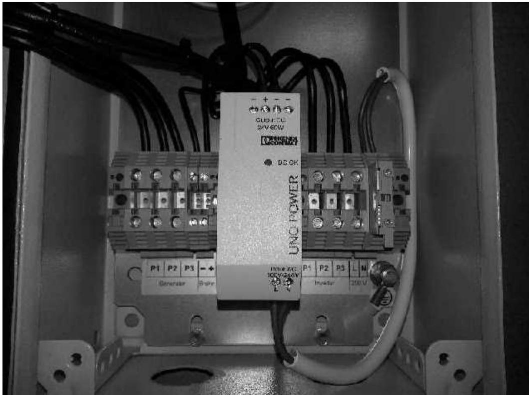
**WARNUNG:** Installieren Sie keine Sicherungen in den drei Leitungen zwischen Windgenerator und AC-Box, da diese beim Kurzschlußbremsen durchbrennen könnten.
